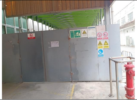
项目一般工业固体废物仓
