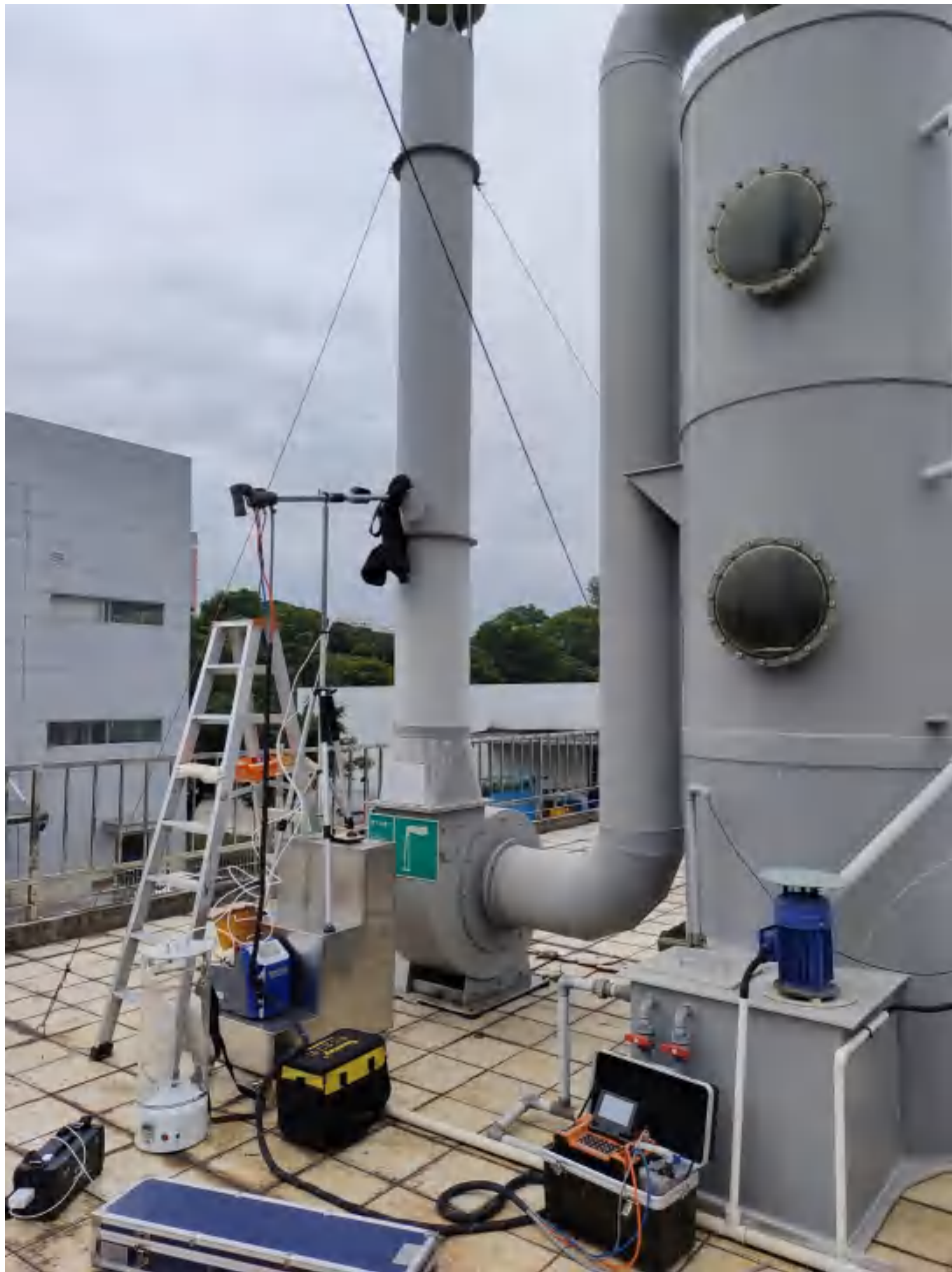
综合废水处理站废气排放口检测
