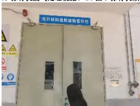
图 3-7 危险废气物储存仓库
