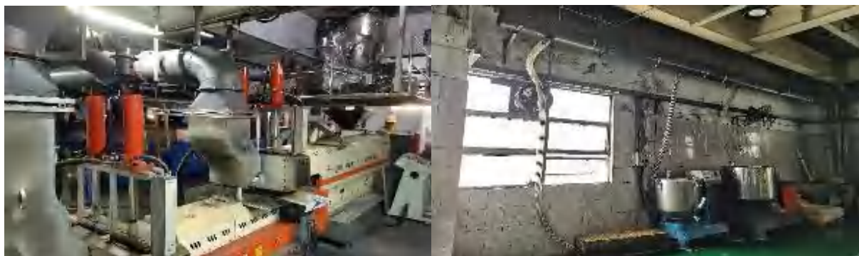
图 2-4 G6 区 5 栋混料、抽粒挤出车间
